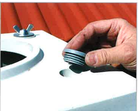
16. Azokat a furatokat, amelyeket nem használtunk, mindig tömítősapkával zárjuk le.
