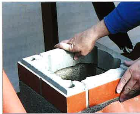
2. Az első Schiedel UNI kéményfej elemet elhelyezzük.
