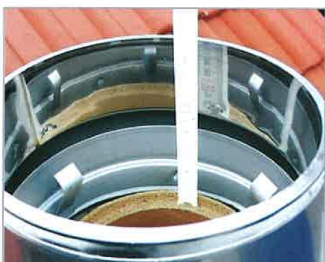
18. A torkolati kúpot szárazon elhelyezzük, lemérjük az utolsó samottcső hosszát a kúp felső síkjáig és a csövet méretre vágjuk.
