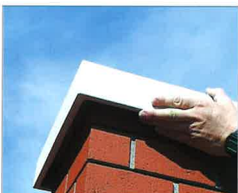
14. A könnyűbeton fedkővet felhelyezzük.
