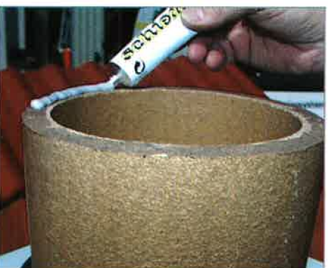
19. Beragasztjuk az utolsó samottcsövet, és a felső élére a torkolati kúphoz adott tömítő pasztát nyomjuk rá.
