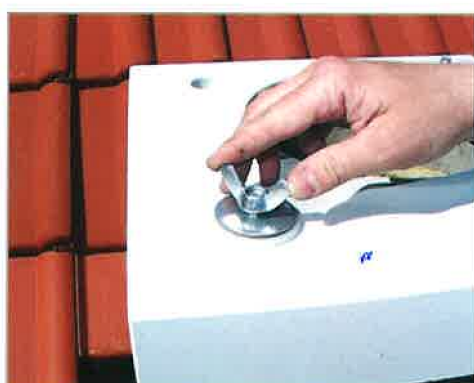
15. Várjunk, amíg a kiöntőhabarcs megszilárdul, majd a fedkővet a tömítőalátét elhelyezése után a szárnyasanyákkal rögzítsük.
