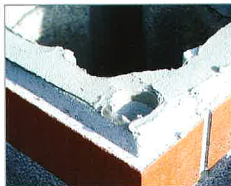
4. A következő Schiedel UNI kéményfej elem alá a készlethez vödörben adott ragasztóhabarcsot vékonyan felhordjuk. Vastagsága átlagosan 2 mm.
