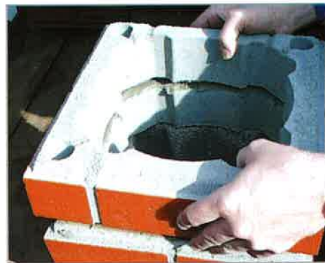
5. A következő Schiedel UNI kéményfej elemet elhelyezzük.
