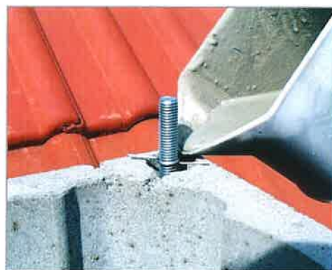
12. A furatban elhelyezett csavarokat a készlethez vödörben adott hig cementhabarccsal kiöntjük.
